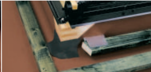
Verkleving met DELTA®-FLEXX BAND aan dakvenster.
