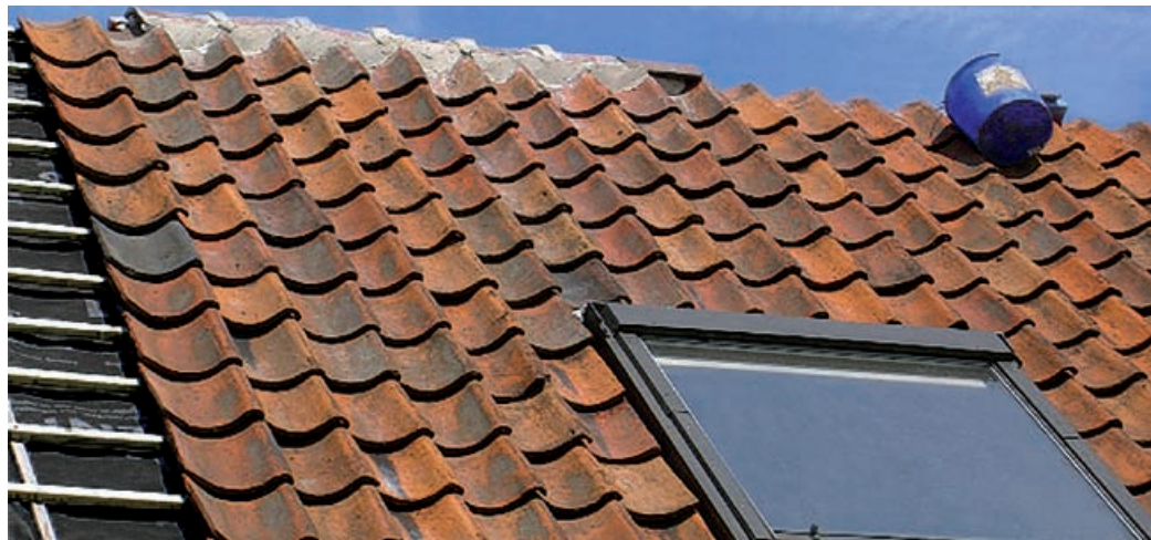
Plaatsing onder Boomse (holle) pannen.
